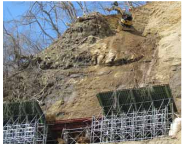
写真-4 クライミングバックホウ使用状況
