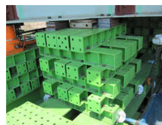
写真6 仮ベントと軌道桁の一体化
