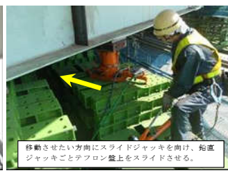
スライドジャッキにて位置調整
