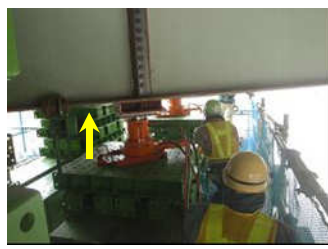
油圧ジャッキアップ 100 t × 2基
