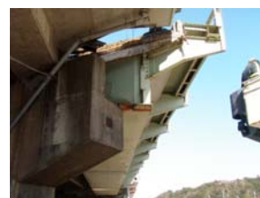
写真-1 桁移動状況
