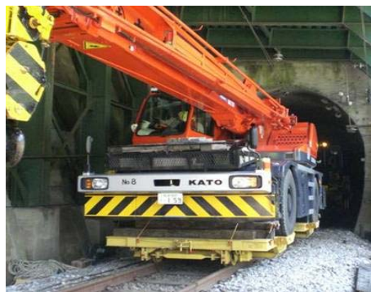
写真-1 25tのラフテレーンクレーン搬入
