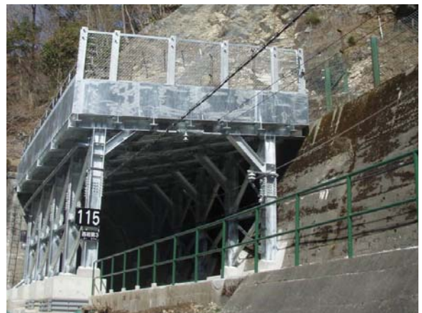
写真-2 完成した落石おおい
