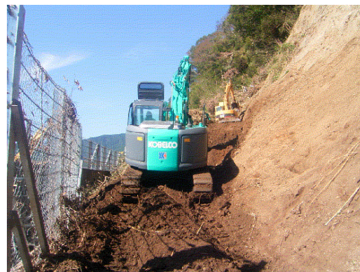
写真-3 浚渫作業の状況
