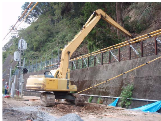
写真-2 樹木の撤去状況
