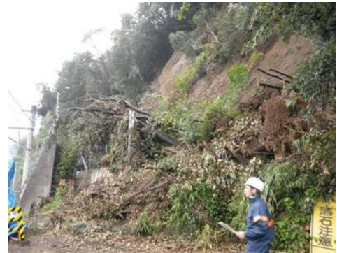
写真-1 被災箇所
