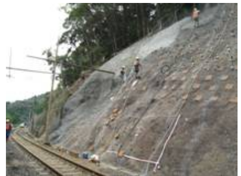
図-7 モルタル吹付 (16 k 付近)
