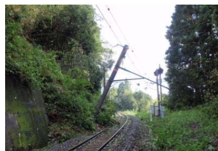
図-1 被災の様子（16 k 付近）
