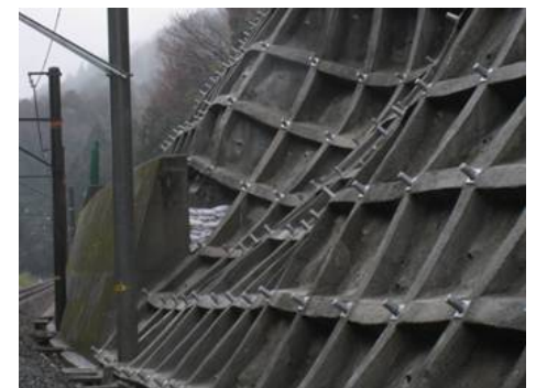
図-8 本復旧後 (16 k 付近)
