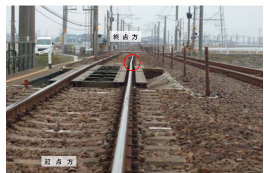
写真-2 橋梁の現状写真
