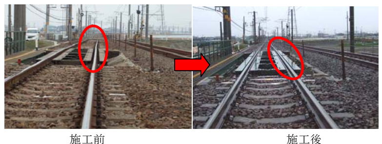
写真-5 橋梁付近の施工前後の状態
