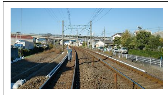
設置完了全景
