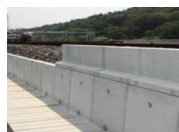
RCバラスト止め敷設
