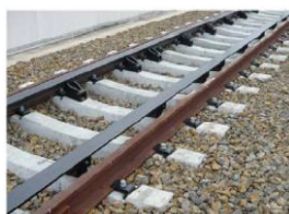
脱線防止ガード敷設
