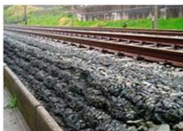
ジオテキサック敷設
