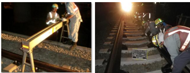
写真－２ レール山越器と人力による敷設
