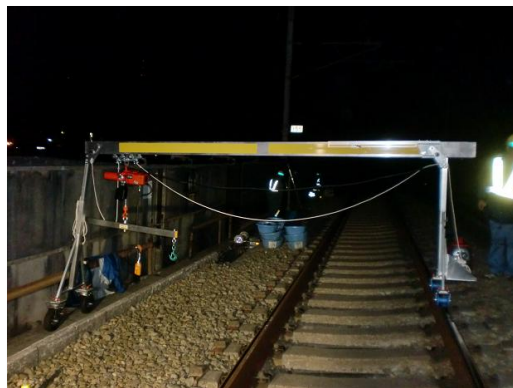
写真－３ 脱線防止ガード専用山越器
