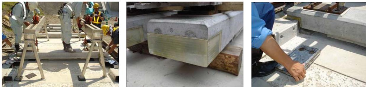
写真-1 試験施工（まくらぎ着脱、縁切材、弾性材の交換）
