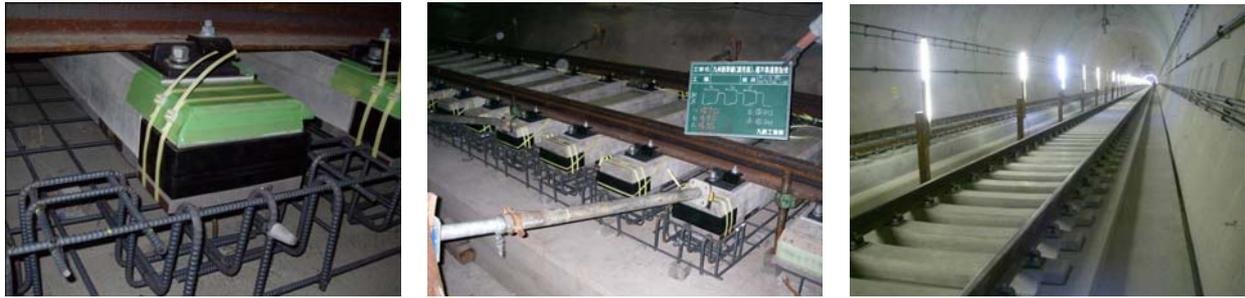
写真-2 施工状況(PCまくらぎ(防振キャップ等付属品取付済)、道床コンクリート配筋、コンクリート打設後)
