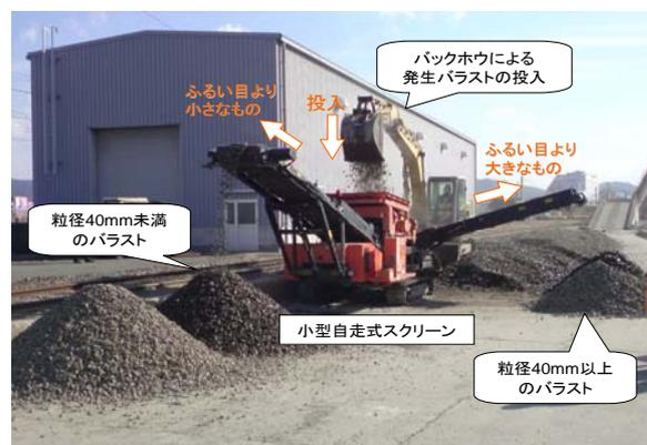
図-2 小型自走式スクリーンを用いたふるい分け作業
