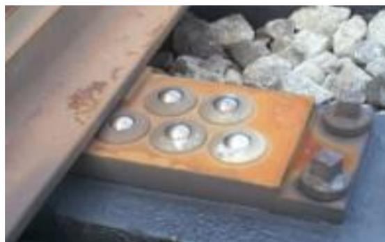
図-1 ボールベアリング床板
