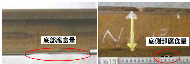
(a) 底部腐食量
