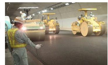
写真-6 放射温度計による測定状況
