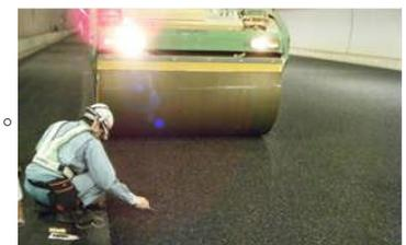
写真-5 挿入型温度計による測定状況
