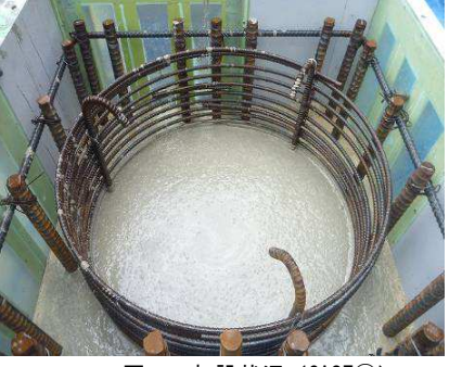
図 5 打設状況 (CASE①)
