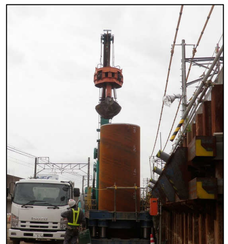
写－4 鋼管圧入掘削施工状況
