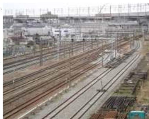
図-5 切換準備作業(分岐器組立)の様子
