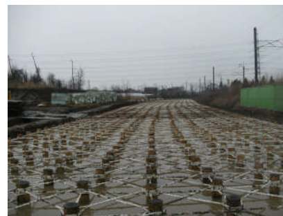
写真-1 パイルネット工完了
