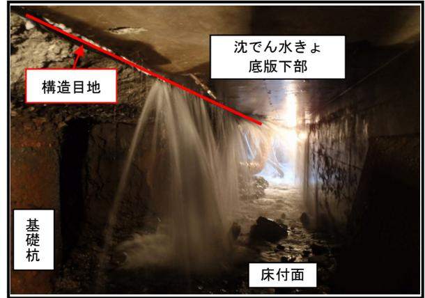
写真-1 漏水状況
