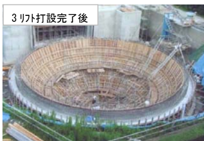
写真-1 底版円錐部型枠組立状況
