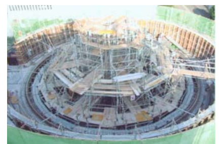
写真-3 頂版円錐部支保工架設状況
