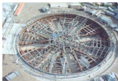
写真-2 内部足場・支保工架設状況
