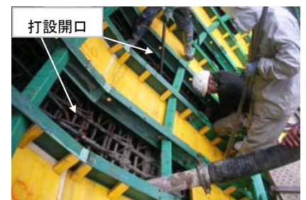
写真-8 コンクリート打設状況
