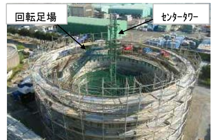
写真-5 センタータワー配置状況
