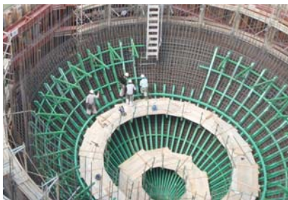
写真-6 底版円錐部支保部材架設状況
