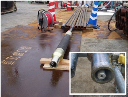
写真1 充填ロッド先端部
