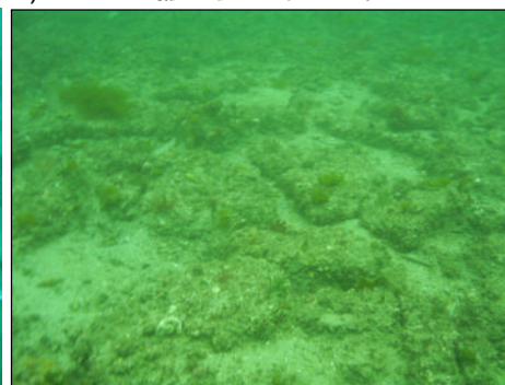
写-1 マウンド天端状況(ケーソン設置位置)
