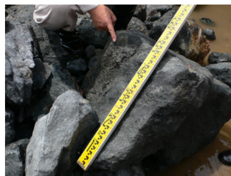
写-2 捨石表面の付着物の状況
