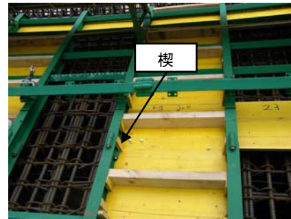
図 5. せき板設置状況
