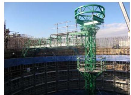
図 6. 回転足場設置状況
