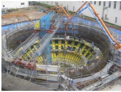
図 4. コンクリート打設状況
