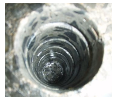
写真2 溝切削孔後の孔内
