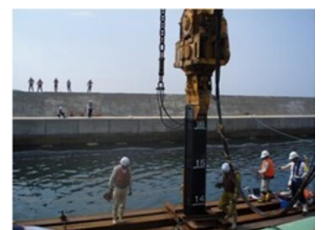
写真-1 試験施工状況
