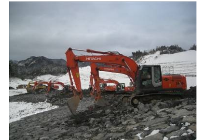
写真-4 盛土(リップラップ)施工状況
