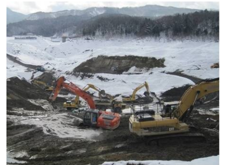
写真-2 厳冬の施工状況
