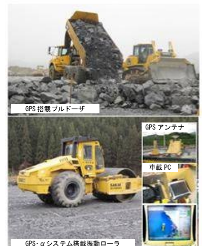
写真-3 まき出し状況と転圧状況
