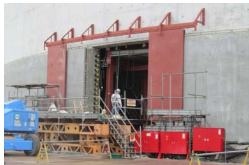
図2.1 工事用開口部(5m×5m)
