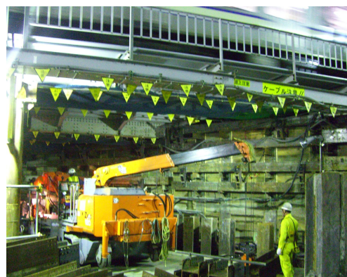
写真-1 施工状況 (工事桁下での施工)
