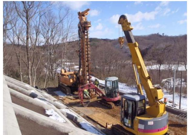
写真-3 抑止杭施工状況(東京方より)
