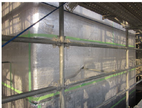
写真-2 養生シートの貼付け状況
