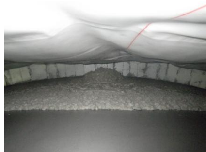
写真1 天端部におけるコンクリートの流動状況
