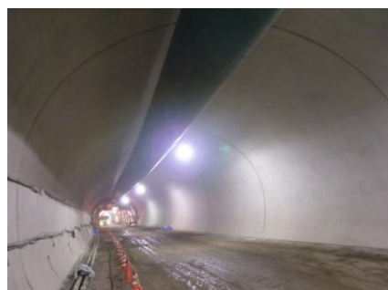
写真2 覆工の仕上り状況
