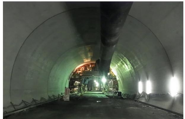
写真-3 覆工コンクリート仕上げ状況
