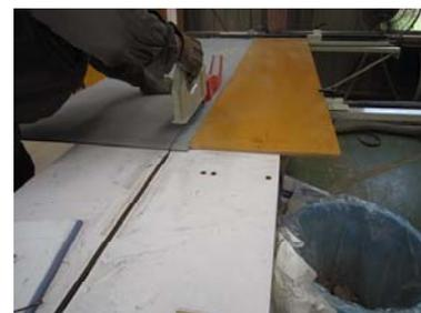
写真-2 樹脂含浸ボードの現場切断
