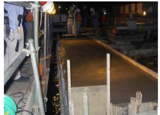
写真-6 コンクリート打設完了
