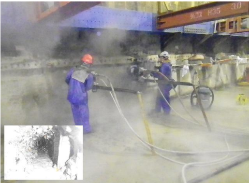
図－5 現場での施工状況
