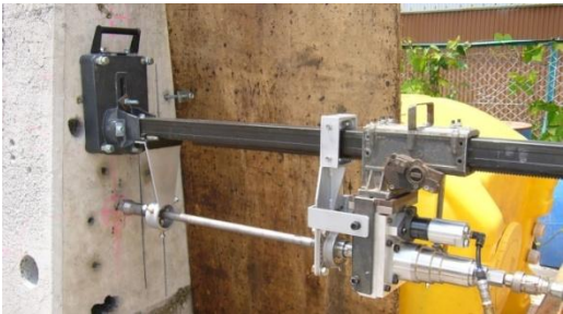
図－4 ウォータージェットはつり装置
