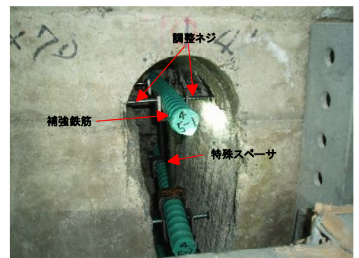
写真3 特殊スペーサで位置決めした補強鉄筋
