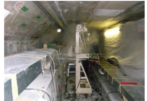
写真2 スリット切削状況
