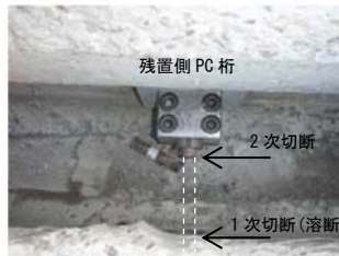
写真-4 PC鋼棒切断
