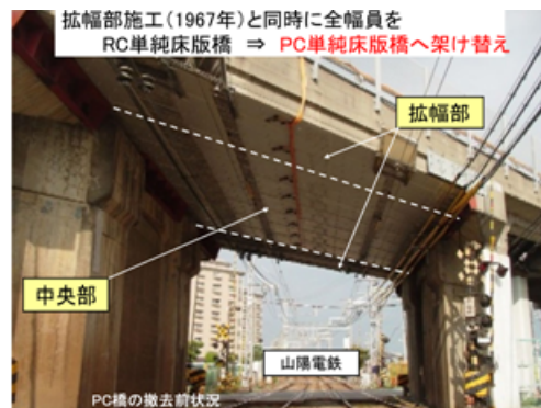
写真-1 PC橋の撤去前状況
