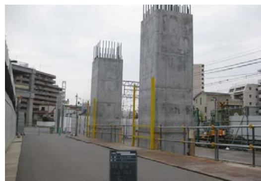
写真-2 構造物の外観 (地中梁および下層柱)
