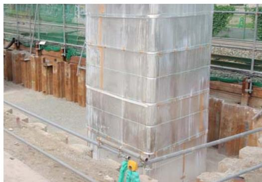
写真-1 高断熱性養生シートによる養生の状況
