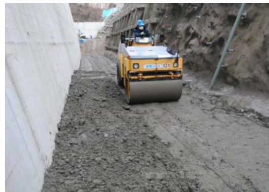
写真-3 振動・転圧状況
