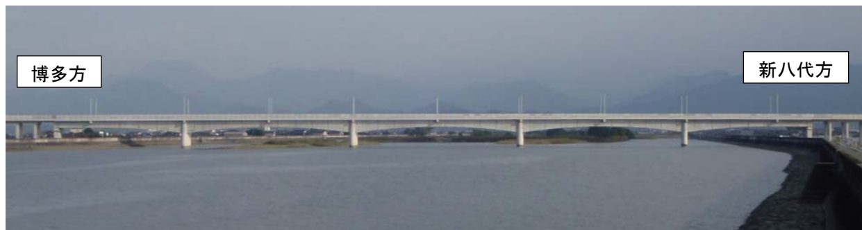
写真-1 氷川橋りょう全景
