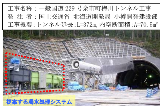
写真-1 濁水処理設備設置概況
