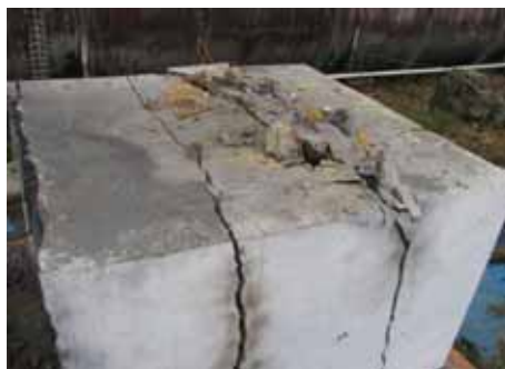
写真－4 はつり破碎状況
