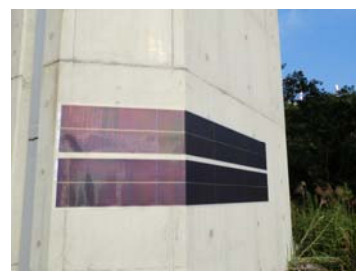
写真-10 橋脚南面
