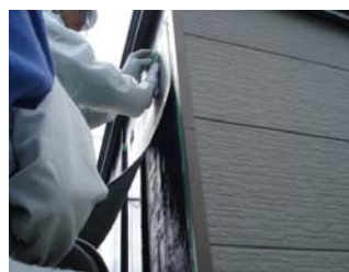
写真-5 PV 貼付
