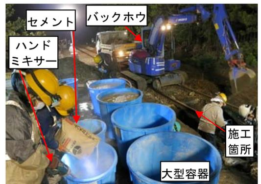
図5 A液・B液の作製と掘削作業状況
