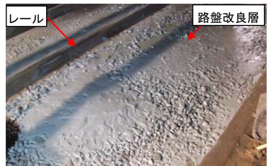
図7 路盤改良層構築後(新バラスト方式)
