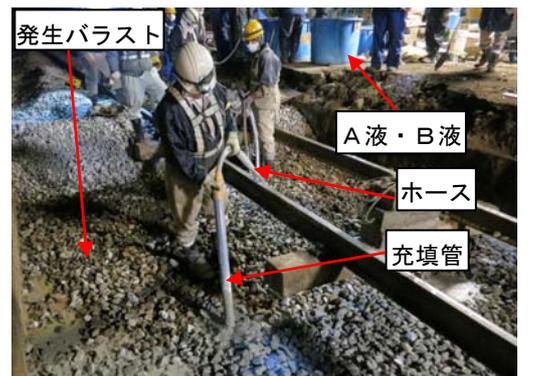
図6 グラウト充填状況(発生バラスト方式)
