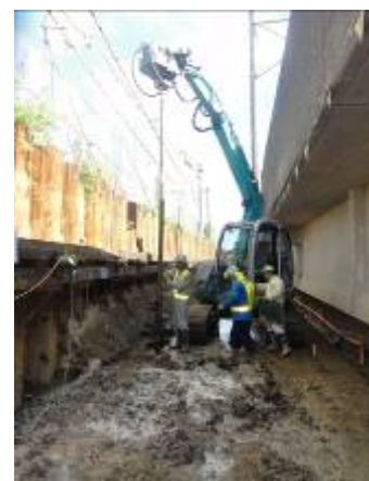
写真-2 本施工の状況
