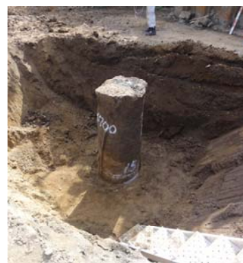
写真-1 露出させた改良体
