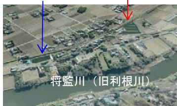
図-2 災害発生前の航空写真
