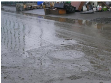
写真-3 対策済みマンホールの例その 1
