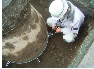
写真-1 トルクレンチによる固定バンドの締付
