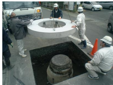
写真-2 浮上抑制ブロックの設置状況
