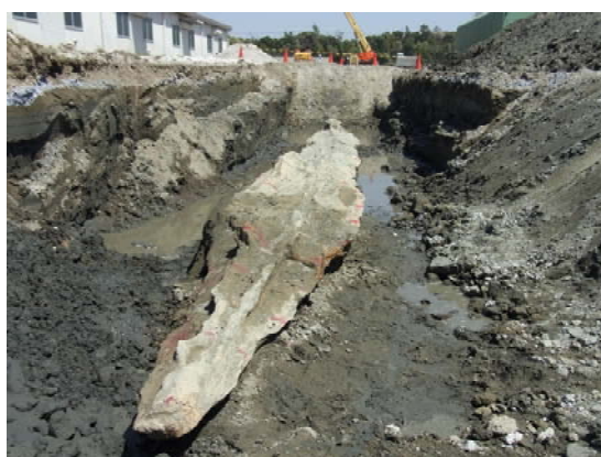
写真-2 固結体の出来形確認
