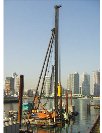
写真-1 施工状況
