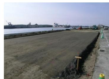
図-6 仙台港の嵩上げ復旧工事路床材への試験適用状況
