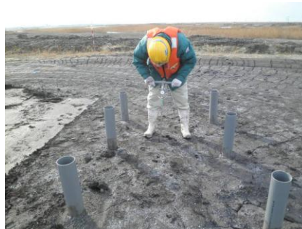
図-6 現地コーン貫入試験状況
